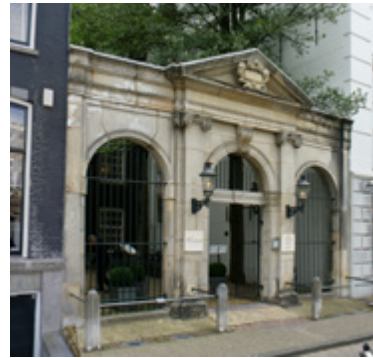
Voormalige Schouwburgpoort; Entree naar hotel The Dylan
